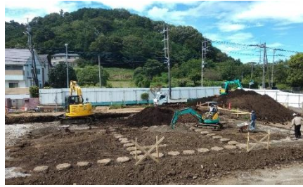
8月下旬 仮設工事
